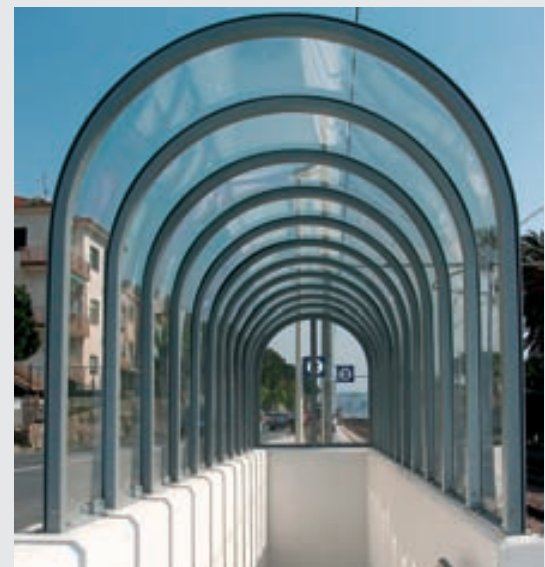
San Giovanni in Persiceto (BO), Stazione Ferroviaria
